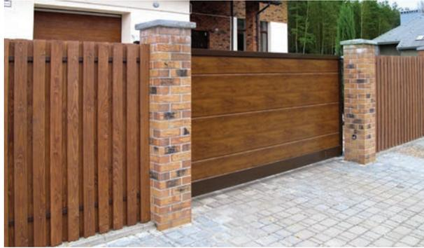
Представляют собой самонесущую конструкцию, когда алюминиевая рама ворот с заполнением перемещается по роликовым опорам, установленным на фундаменте вне зоны проезда ворот (за проемом).
